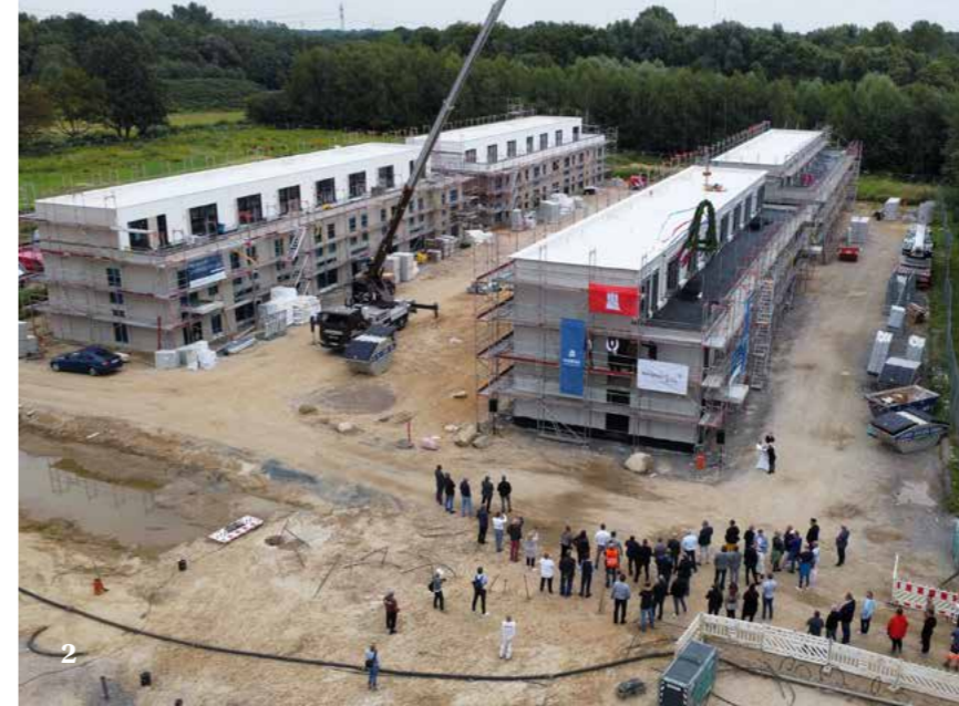
Fotografie // MH3 Ingenieure
