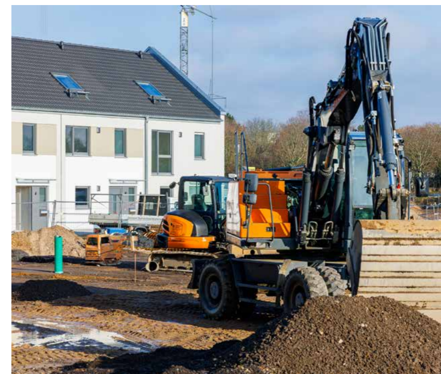
Vorbereitungen für den nächsten VISTA Bauabschnitt
