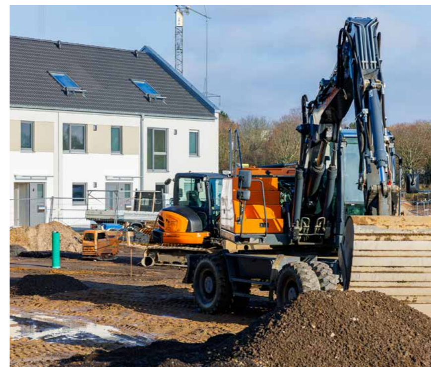
Vorbereitungen für den nächsten VISTA Bauabschnitt
